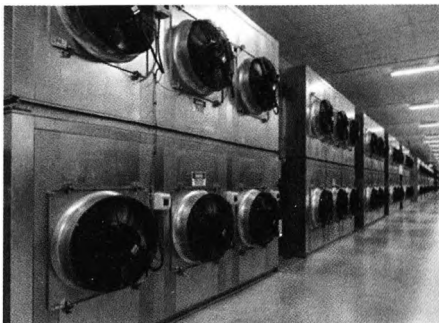
图 6-13 冷空气吹入包含服务器通道的房间内部。热空气通过大型管道进入顶棚，在这里冷却后再返回这些风扇
